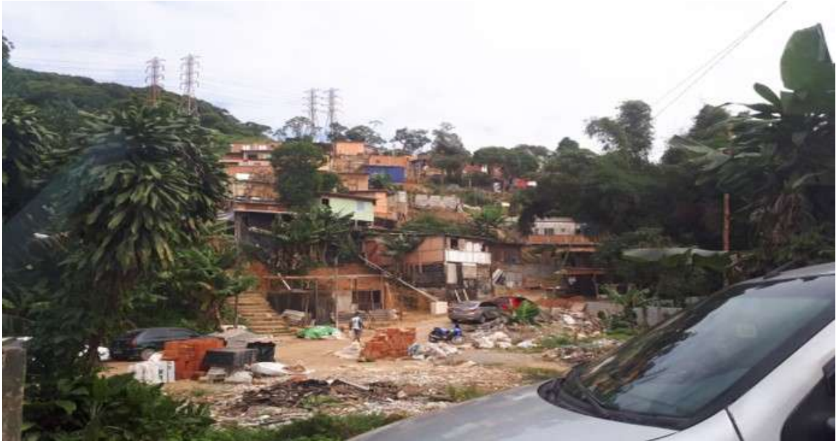
Figura 2. Imagem atual do local com desmatamento efetuado e a ocupação com construções irregulares. Nota-se a inclinação superior a 45°.
