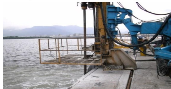
Figura 2. Equipamento de execução de JG.
